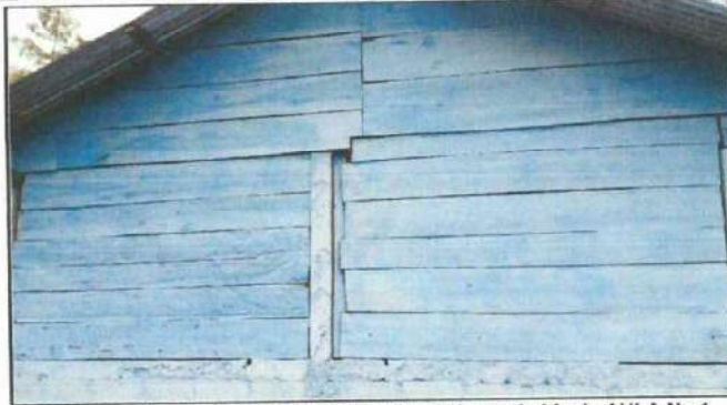
Foto 2: Sustitución de madera para el seguimiento de block. AULA No.1
