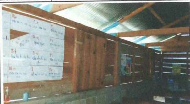
Foto1: Sustitución de madera con ventana de vidrio y sustitución de reglas y vigas de madera por costaneras, laminas y vigas de metal. AULA No.1
