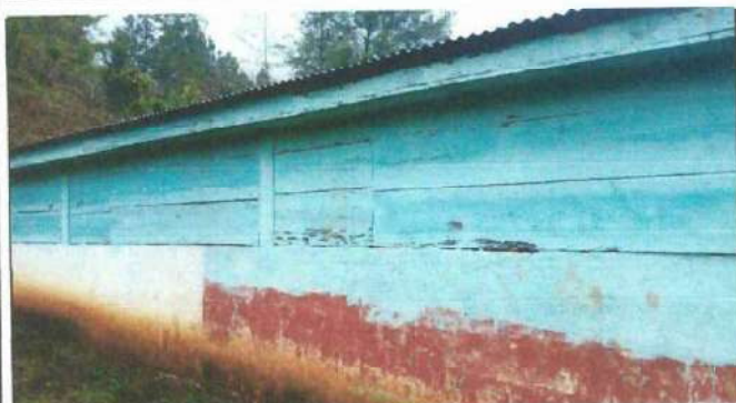
Foto 3: Sustitución de madera por ventanas hechas de vidrio y el techo cambiarlo por costaneras, vigas y laminas. AULA No.2
