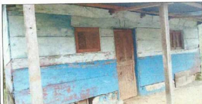
Foto 5: Sustituir la madera por block y las puertas de madera por unas nuevas de metal. COCINA
